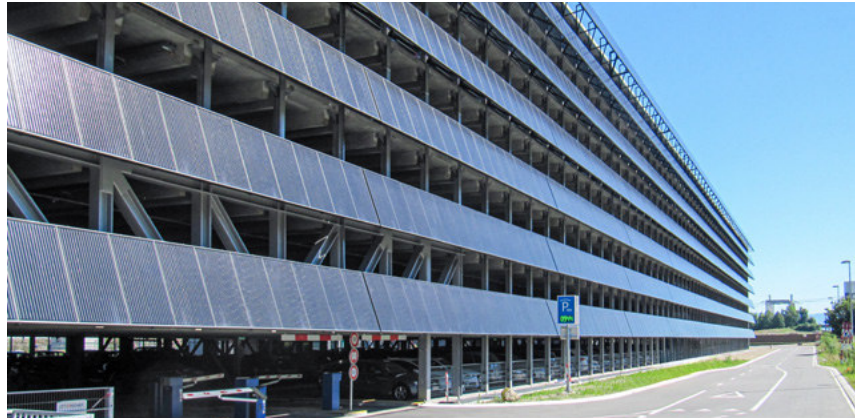
Abb. 26: Solarstromanlage, die in das architektonische Konzept des Parkhauses integriert wurde
