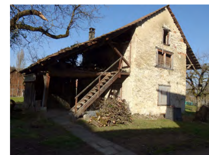
(B) Gebäude Nr. 111, Süd- und Westseite
