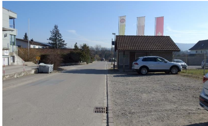
Abbildung 7: Trafohäuschen, Ansicht von Norden (2021)
