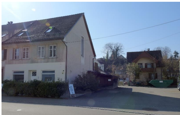
Abbildung 31: Baufläche für Baukörper T (2021)
