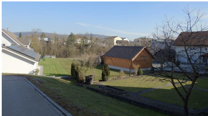
Abbildung 17: Ansicht Garage (Gebäude Nr. 200) von Süden her (2021)
