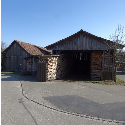
Bestehende Bauten D'
