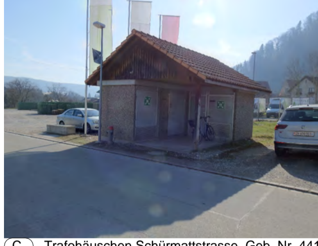
C) Trafohäuschen Schürmattstrasse, Geb. Nr. 441,
