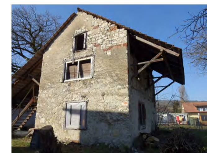
(B) Gebäude Nr. 111, alte Hafnerwerkstatt Südseite
